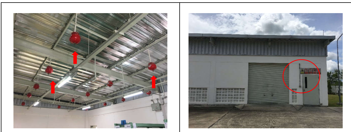
รูปถ่ายที่ 3.2-49 : ระบบดับเพลิงและระบบเตือนภัย บริเวณอาคารเก็บสารเคมี
