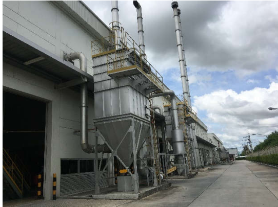
รูปถ่ายที่ 3.2-1 : ระบบดักฝุ่นแบบถุงกรอง
