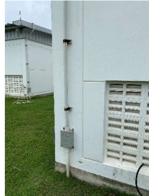
รูปถ่ายที่ 3.2-44 : อุปกรณ์ป้องกันไฟฟ้ารั่ว (สายดิน)
